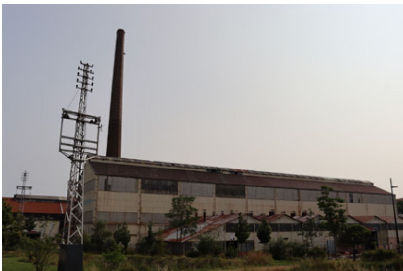
Figura 16. Estructuras industriales recuperadas y reutilizadas.
